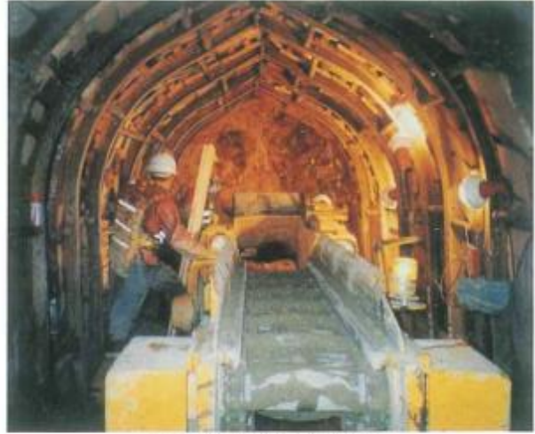
木之川内導水路掘削状況
