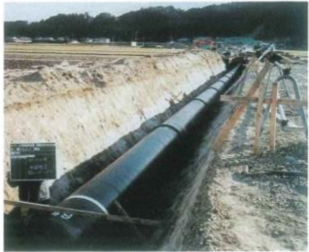
幹線用水路埋設状況
