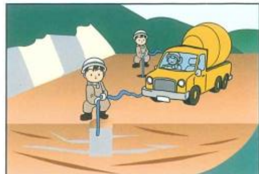
基礎処理工事
