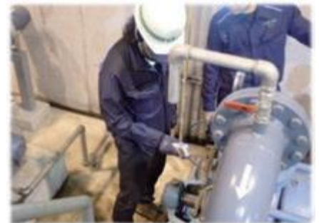
④パッキン交換後試運転点検
