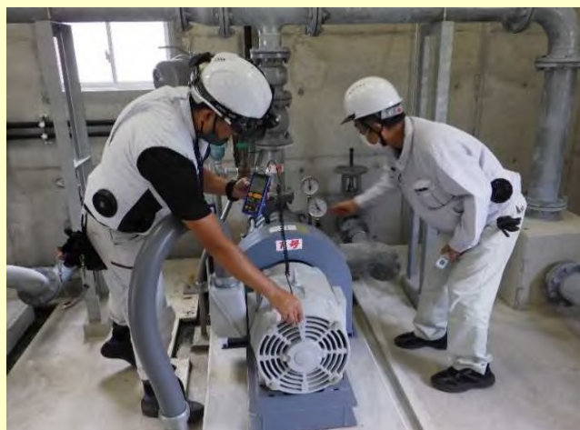
ポンプ設備点検
