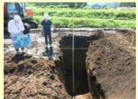
掘削深度確認(約3m)
