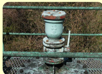
空気弁発錆
