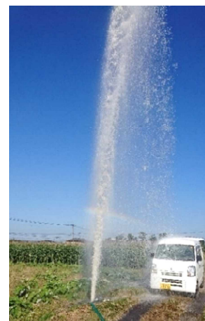
給水栓破損による漏水
