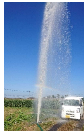
給水栓破損による漏水
