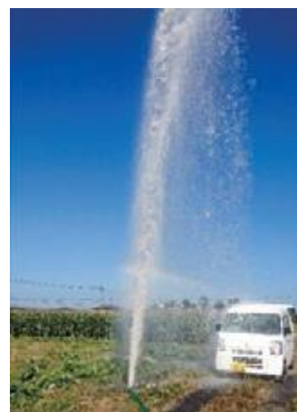
給水栓破損による漏水
