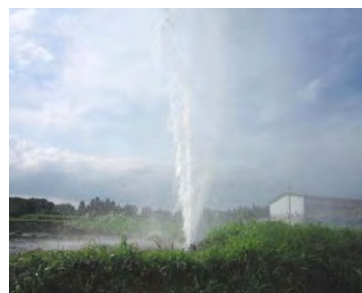
トラクターによる給水栓破損
