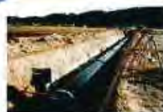
パイプライン
