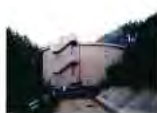
ファームポンド (貯水タンク)
