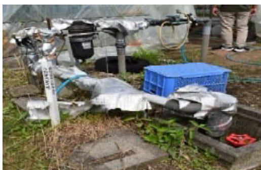
給水柱から散水器具の間に 接続しているろ過器や散水タイマー
