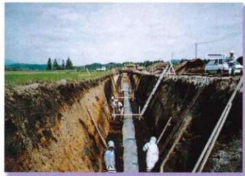
末端の畑地に排水する 幹線用水路工事
