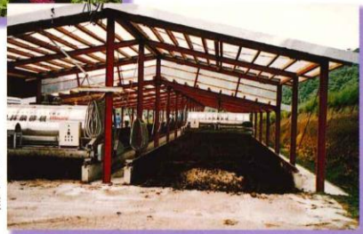
良質堆きゅう肥生産施設 都城市 北諸地区では69ヶ所に堆肥センターがあり7万7000トンの堆肥を生産農家に販売し畜産資源を活用した土づくりを推進している。
