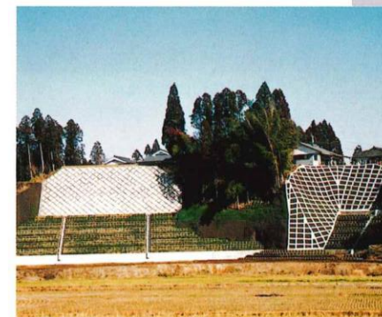
災害復旧治山事業 高崎町
