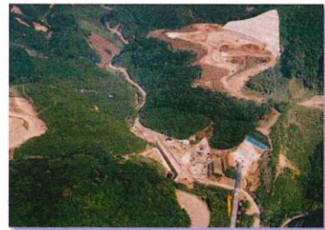
工事がすすむダムサイト付近
