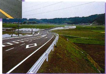
建設がすすむ 公団広域農道
