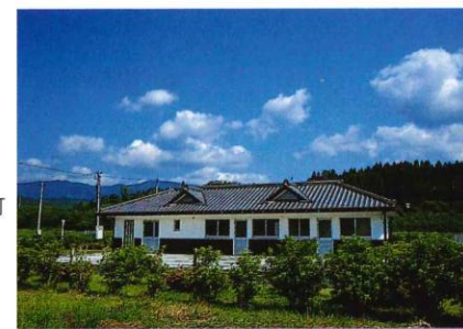
都市並みに生活排水を 浄化する農業集落排水施設 山之口町
