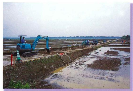
大型水田に生まれ変わる基盤整備 (50ha) 都城市・大島団地 農用地整備公園が9団地合わせて167ha を整備中 (平成8年度～13年度)
